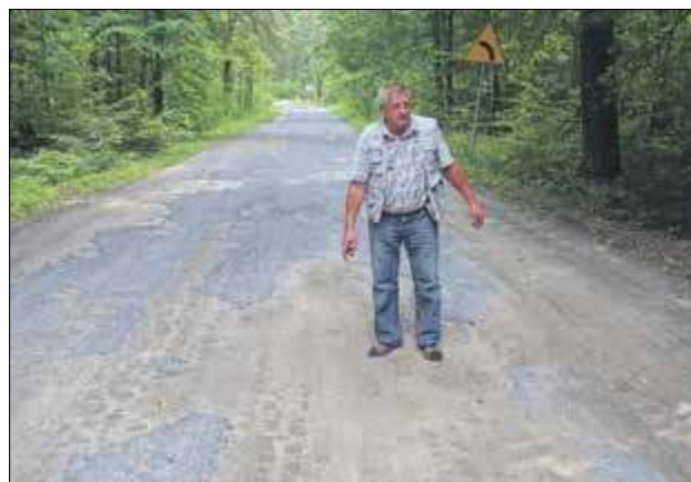
Witold Bujalski wraz z innymi mieszkańcami Stasiówki budował tę drogę w 1992 r. Nie chce, aby cały wysiłek poszedł na marne
