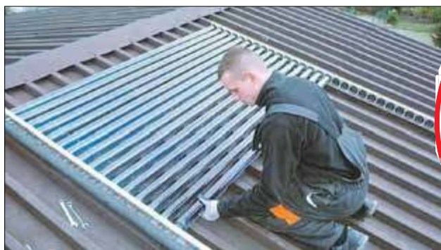
Kolektor próżniowy składa się z kilkunastu rur szklanych, w których znajdują się rurki z absorberem. Lepiej sprawdza się jesienią i zimą
