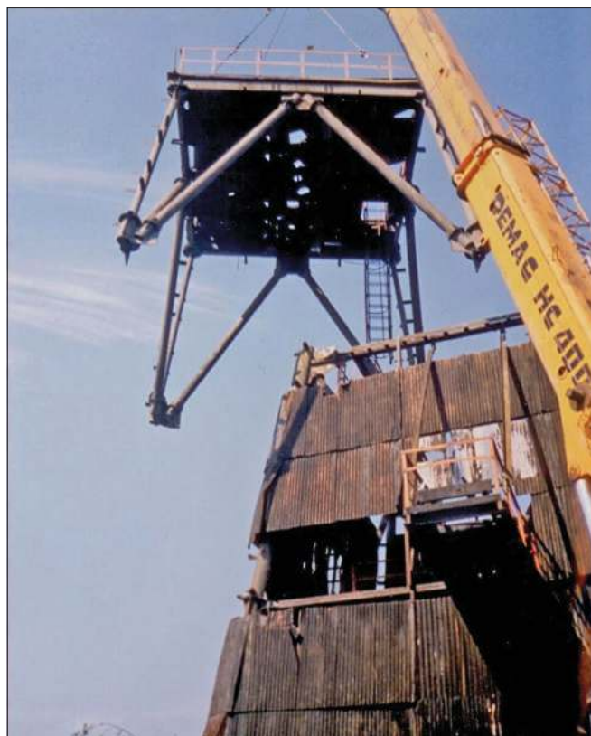
Szyb VII w trakcie likwidacji
