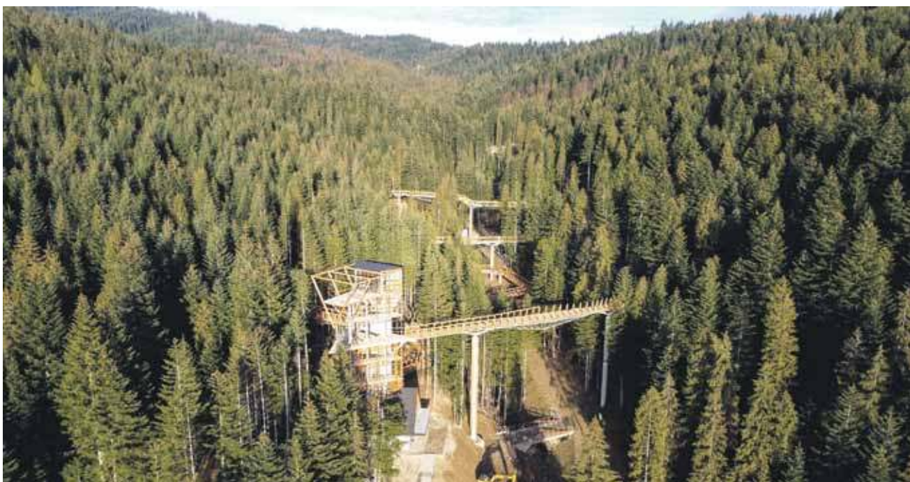
Ścieżki w koronach drzew są już niemal gotowe.
