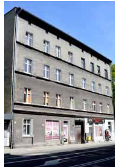
W kamienicy założone zostanie centralne ogrzewanie, w mieszkaniach będą toalety. Elewacja budynku również zostanie odnowiona
