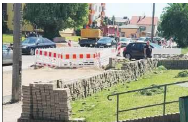
Przebudowywana ul. Wyszyńskiego nie będzie miała bezpiecznego przejścia. W ramach remontu o przebudowę przejść nie zadbanano
