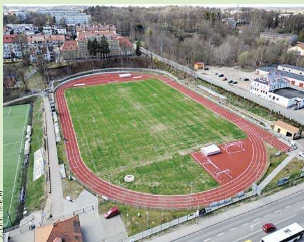
Zmodernizowany stadion w Mrągowie
