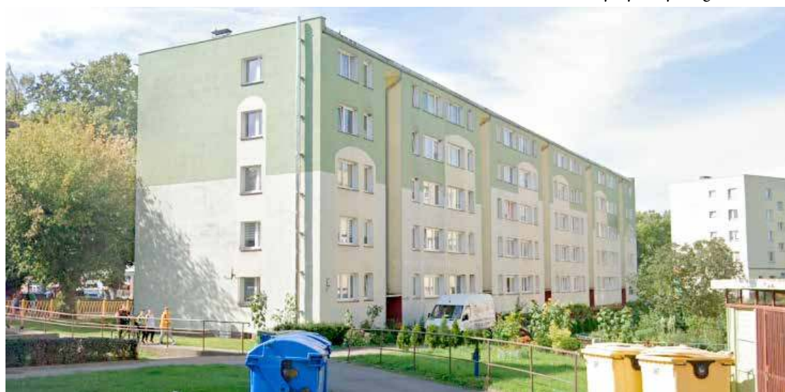
Zadymieniu uległo jedno z mieszkań na parterze budynku mieszkalnego
