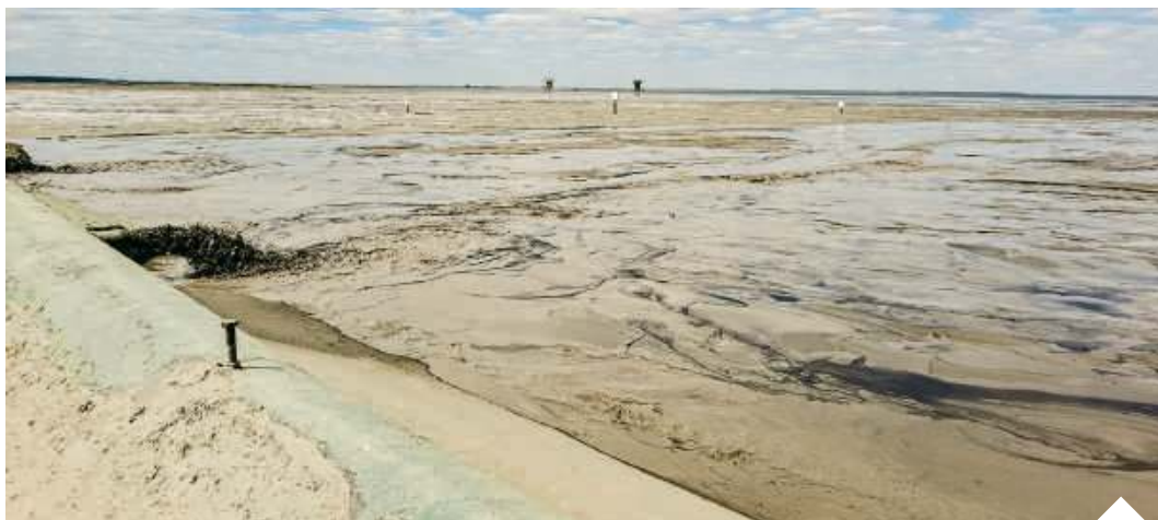
KGHM zdecydował o rozbudowie Żelaznego Mostu o tzw. kwaterę południową, której docelowa powierzchnia wyniesie 610 ha | fot. Andrzej Ratajczyk/Gazeta Polska
