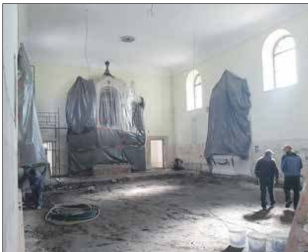
W ramach remontu zostanie wymieniona posadzka i założone ogrzewanie podłogowe
