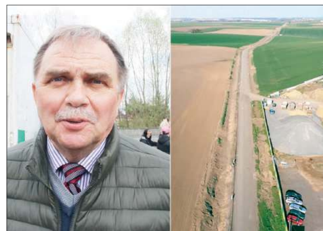
▲ Wójt Andrzej Wawrzynek mówi, że dzięki współ- pracy samorządów można było wypracować dla użytkowników drogi wojewódz- kiej nr 416 lepsze objazdy. Na zdjęciu obok remontowany trakt. FOT. KRYSPIŃ STRZONDAŁA
