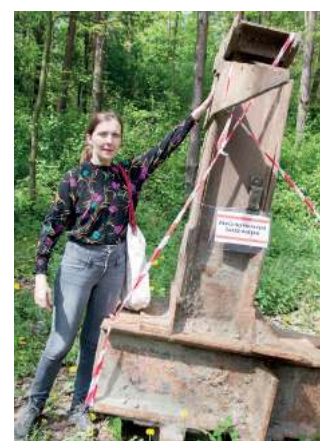
■ Zapory przeciwzołgowe tego typu znajdowały się nad i pod ziemią – u góry znajdował się szlaban forteczny z mocowaniem, natomiast do gruntu wkopywano długie wzmocnienie, które zapewniało konstrukcji stabilność potrzebną do zatrzymania pojazdów opancerzonych. Wkrótce zaporę przeciwzołgową w Oborze również zostanie częściowo wkopana w ziemię.
