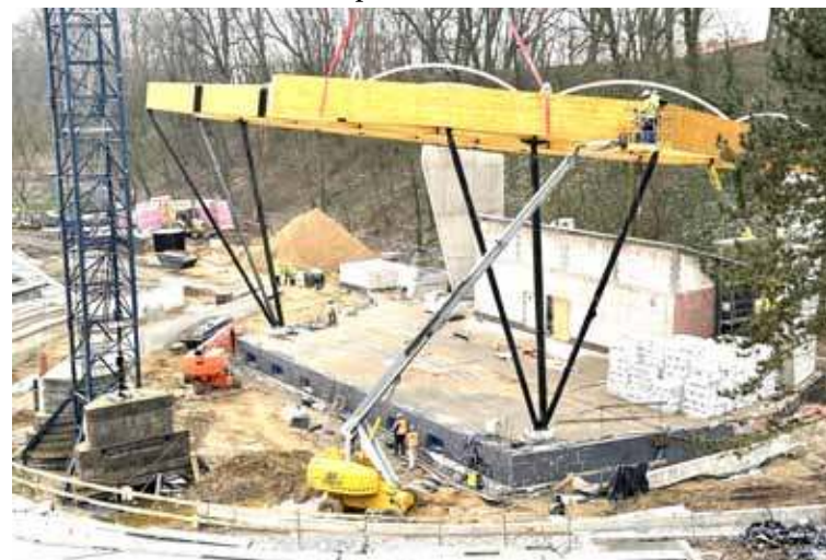
W budynku sceny prowadzone są roboty wykończeniowe.
