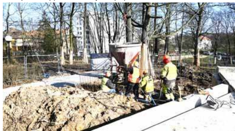
Wykonawca zajął się także zagospodarowaniem terenu wokół amfiteatru
