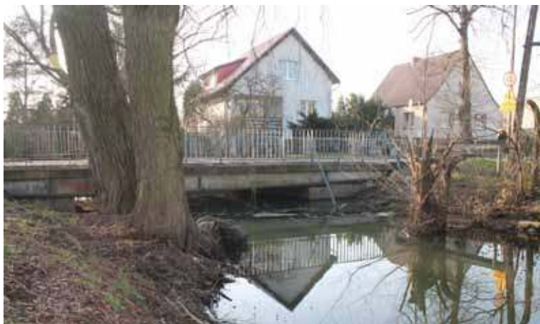
Mieszkańcy pytają, kiedy problem zostanie skutecznie rozwiązany. Wody Polskie właśnie poinformowały o rodzaju i prac i terminach ich realizacji
