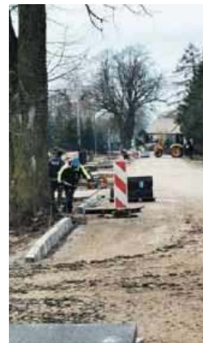
Przebudowa chodnika – Wielki Łęck
