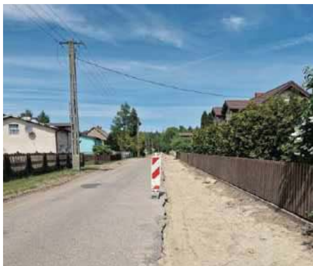
Przebudowa chodnika w miejscowości Bryńsk
