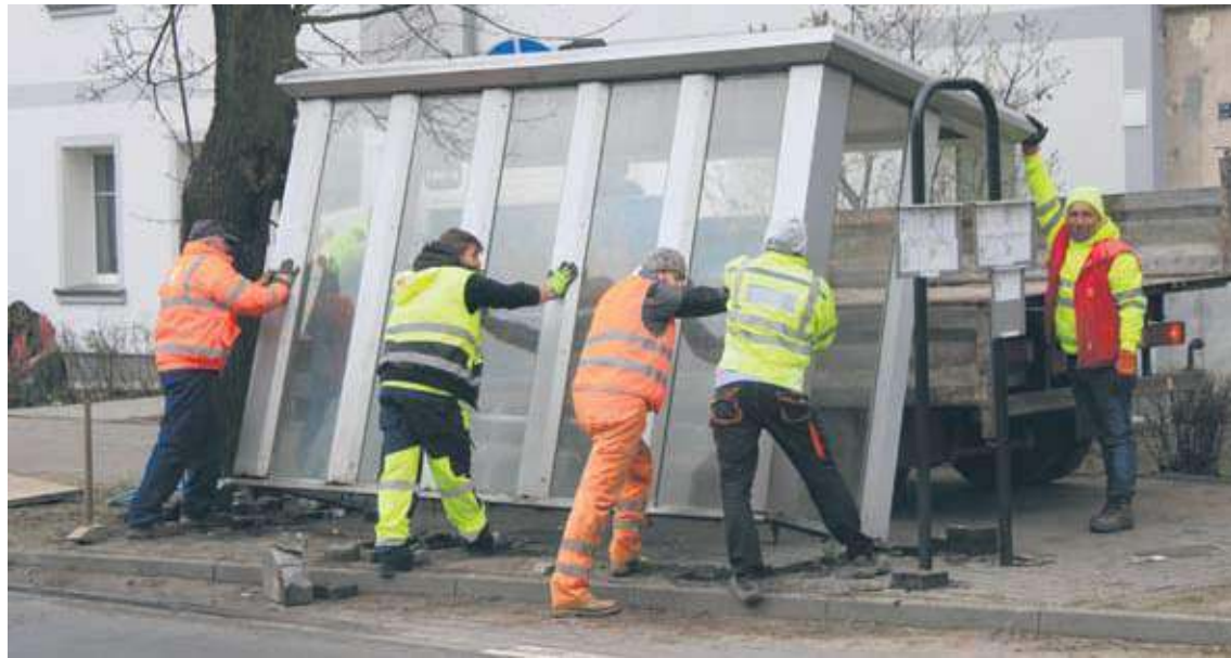
(al) W miejsce zdemontowanych staną nowe, większe wiaty przystankowe
