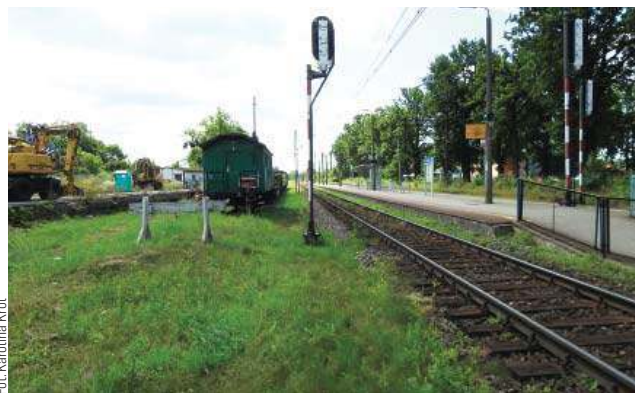
Stacja w Pasłęku zostanie przebudowana
