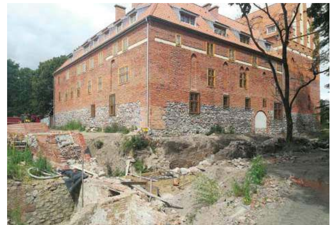
Wokół zamku wciąż trwają prace przy murach obronnych
