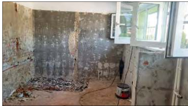
Prace związane z remontem łazienek w budynku po byłym gimnazjum w Gogolinie jeszcze trwają.
