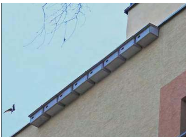
Takie budki dla jerzyków zamontowano na budynku w Otmęcie.
