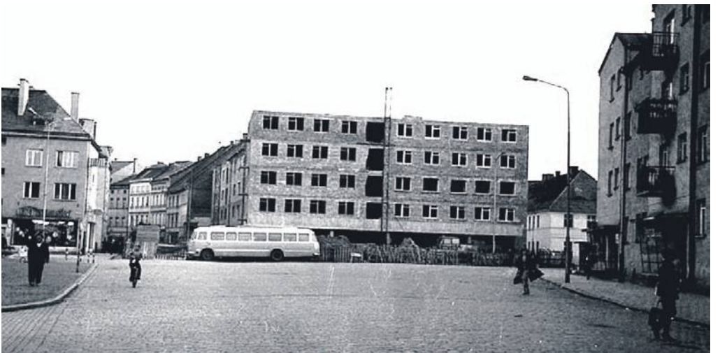
8. To zdjęcie w 1966 roku wykonałem w czasie budowy ostatniego budynku mieszkalnego w Ryнку ze sklepem meblowym na parterze
