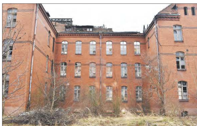
W budynku obok ul. Legnickiej prowadzone są prace porządkowe
