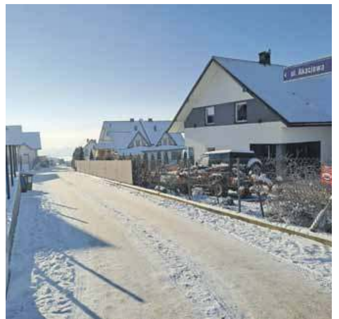
Przy ul. Akacjowej domy są ogrzewane pompami ciepła, ale problem się zaczyna, gdy brakuje prądu.
