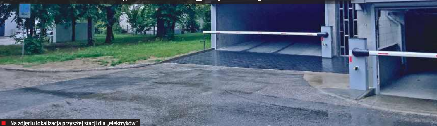
Na zdjęciu lokalizacja przyszłej stacji dla „elektryków”
