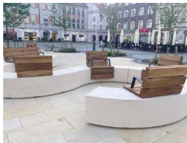
■ Siedzisko betonowe na raciborskim rynku z zamontowanymi na nim ławkami – zdjęcie z 23 września 2026 roku
