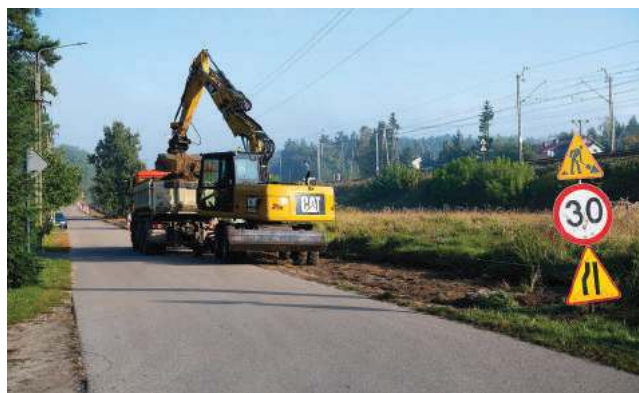
Budowa ciągu pieszo-rowerowego - ulica Kolejowa
