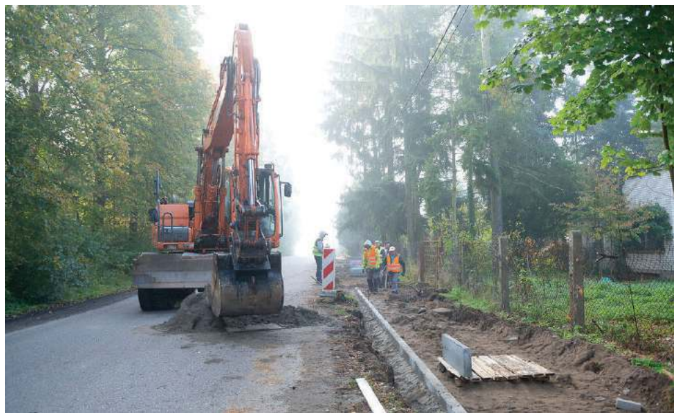
Budowa chodnika i ścieżki rowerowej - ulica Sportowa
