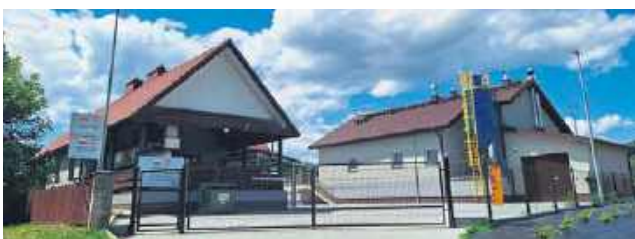
Oczyszczalnia w Tęgoborzy
