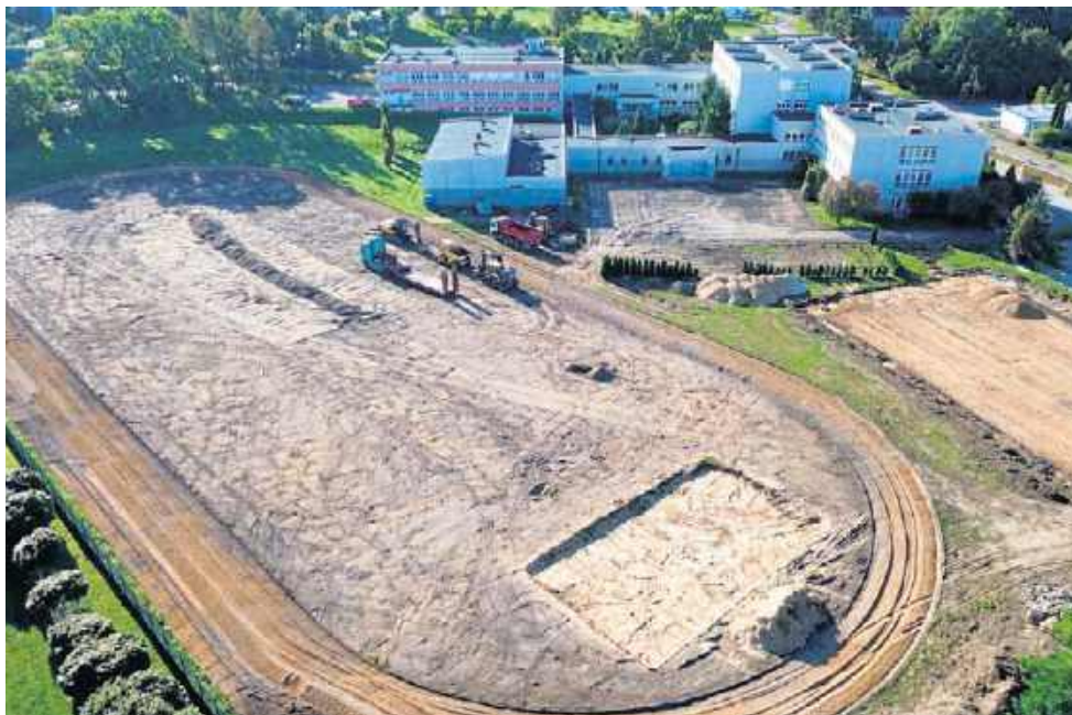
Ruszyły prace przy SP nr 8 w Chrzanowie. Stare boiska i bieżnia zniknęły
