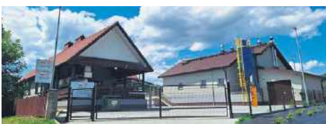
Oczyszczalnia w Tęgorz
