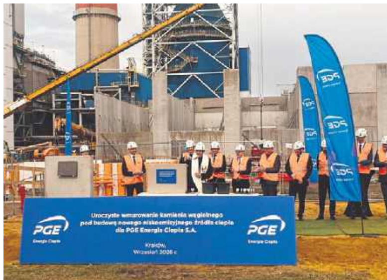
Uroczyste wmurowanie kamienia węgielnego pod inwestycję
