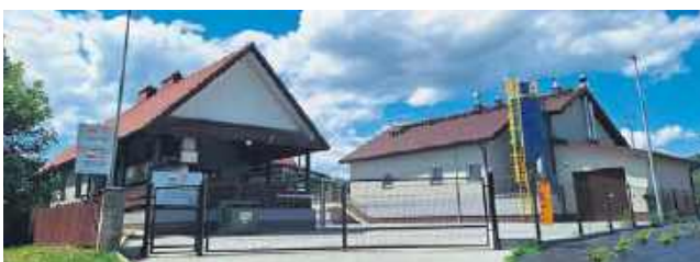
Oczyszczalnia w Tęgoborzy
