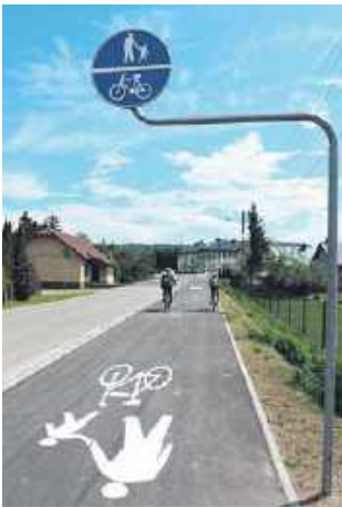
Wybudowano wiele odcinków ścieżek pieszo-rowerowych. Powstają kolejne.
