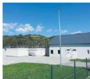
Stacja uzdatniania wody
