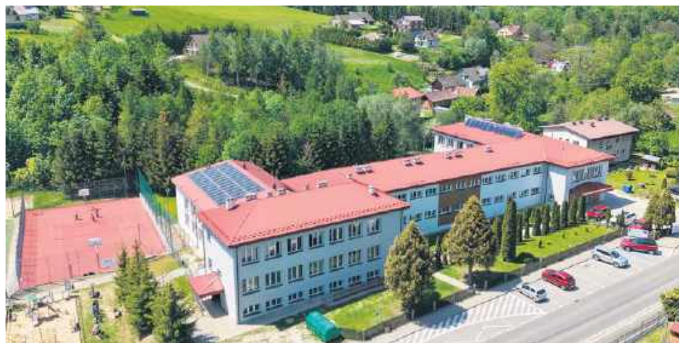
Lipnica Wielka - szkoła po termomodernizacji 2026 i zmodernizowany ORLIK 2025
