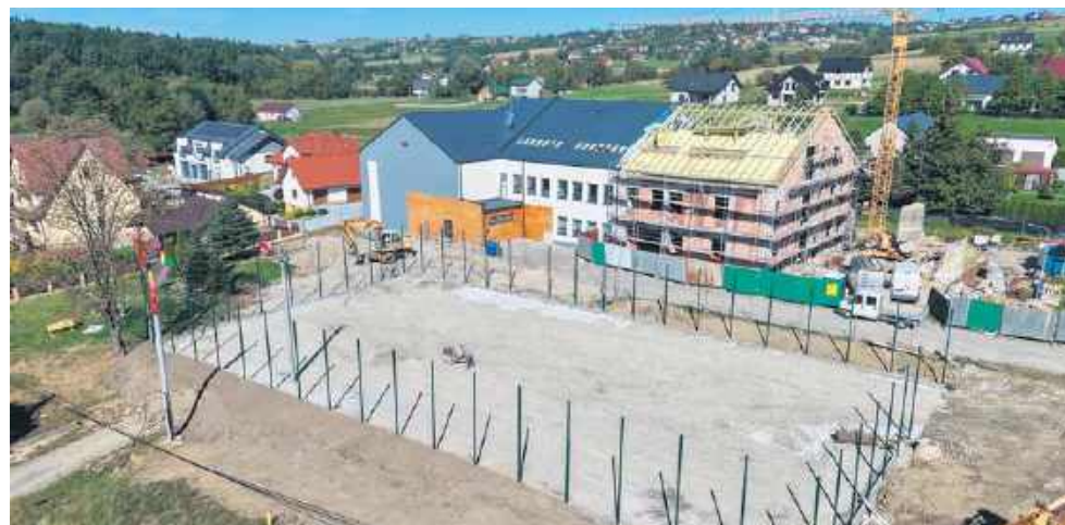
Rozbudowa szkoły i budowa boiska w Łęce
