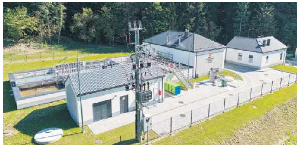
Oczyszczalnia ścieków w Łęce
