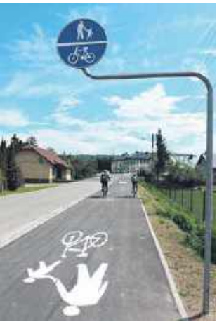
Wybudowano wiele odcinków ścieżek pieszo-rowerowych. Powstają kolejne.
