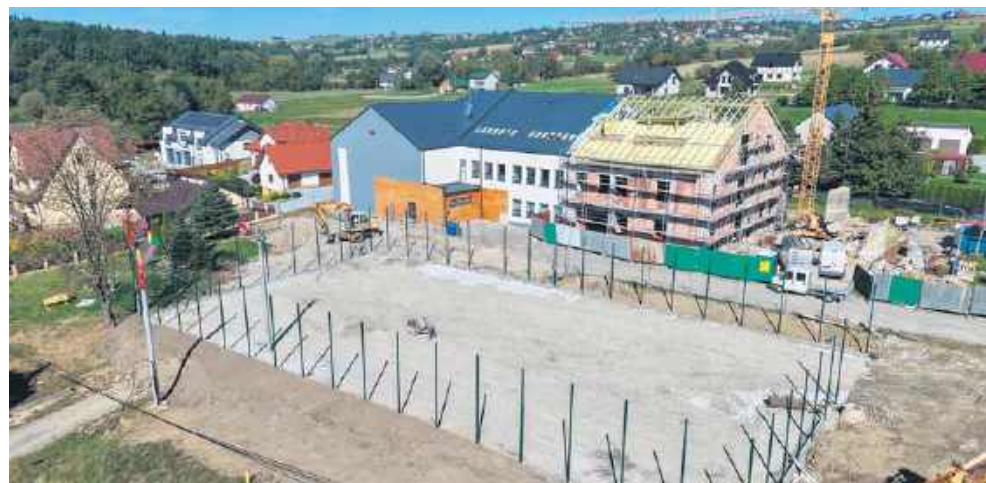
Rozbudowa szkoły i budowa boiska w Łęce
