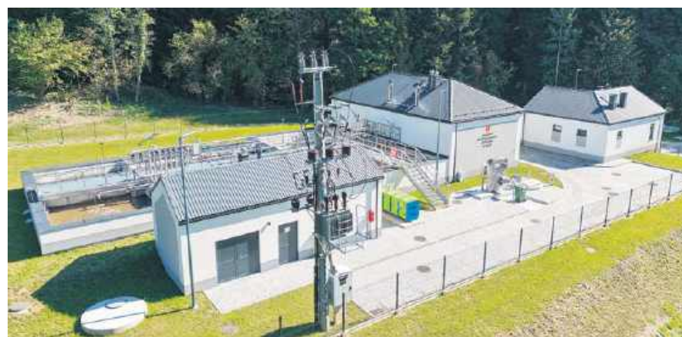
Oczyszczalnia ścieków w Łęce
