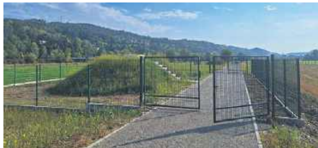
Ujęcie wody w Witowicach Dolnych
