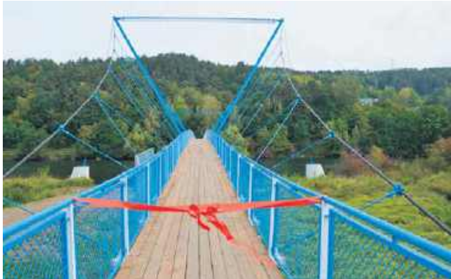
Kładka wisząca pieszo-rowerowa Witowice Dolne- Tropie
