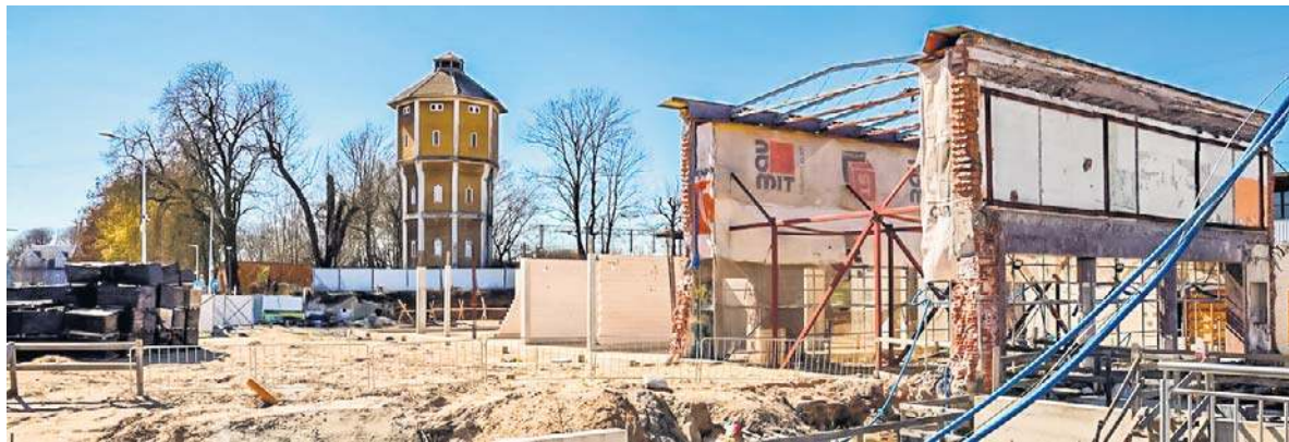
Pozostałości po byłym budynku dworca - stan obecny
