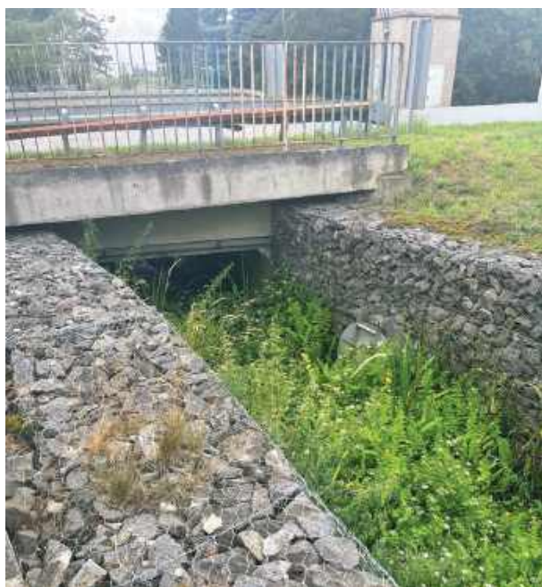
Przepust pod drogą w Rakowicach. Kamienne umocnienia brzegów w wielu miejscach zarastają dziką roślinnością
