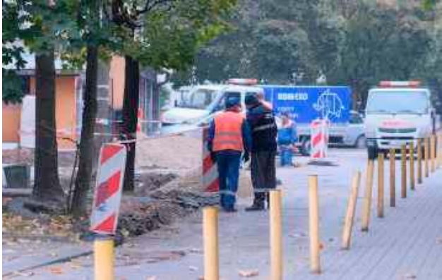
Remont ul. Sokolej ma potrwać do końca listopada
