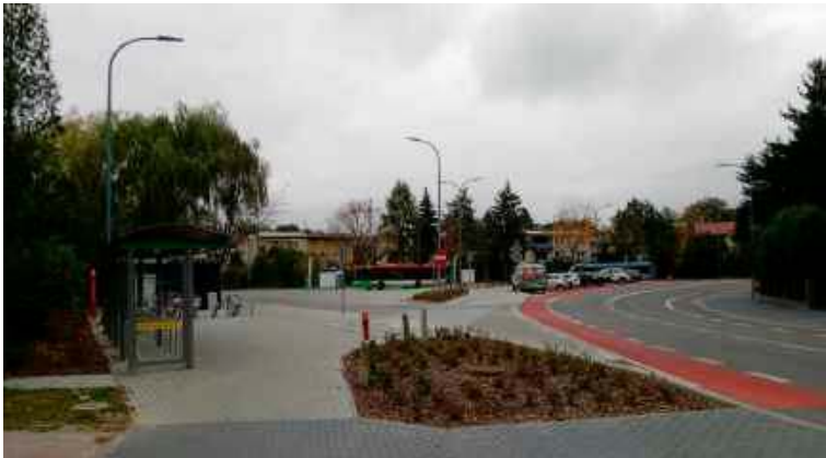
Węzeł przesiadkowy przy Zbożowej gotowy
