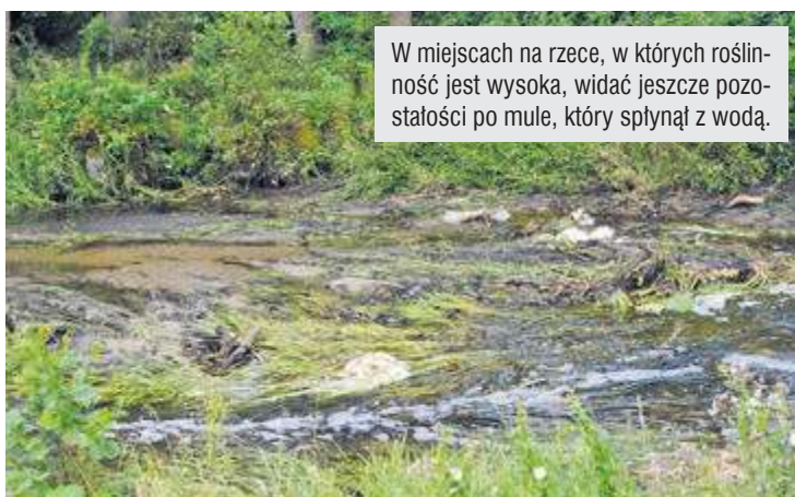
Woda została spuszczone ze zbiornika, ponieważ właściciel elektrowni chciał wyremontować most znajdujący się w trakcie drogi powiatowej łączącej Łąg i Wojtal. Konstrukcja nie jest w najlepszym stanie.
