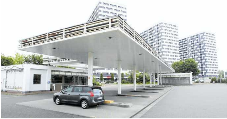
• Ogołocona z części elementów stacja paliw przy ul. Ostrobramskiej 71. W tle po prawej stronie widać pawilon myjni, przy którym 28 lat temu zginął policyjny pirotechnik podkomisarz Piotr Molak
