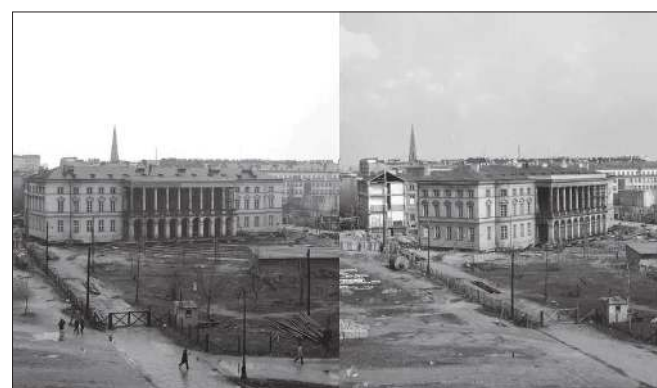
■ Etapy przesuwania bryły pałacu Lubomirskich
