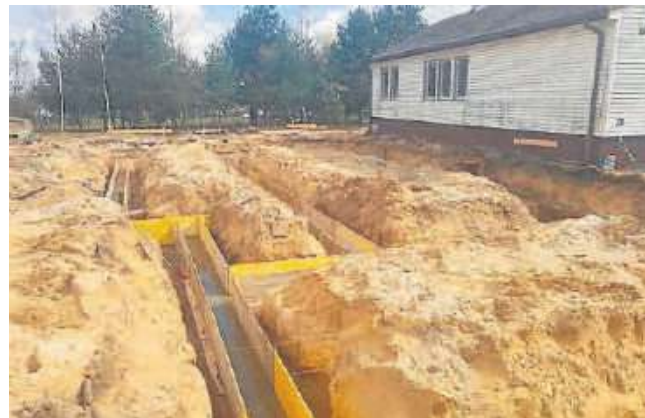
W Dobieszynie są szykowane fundamenty nowego ośrodka zdrowia. Budynek ma być gotowy w grudniu tego roku.
