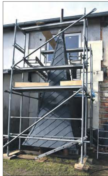
Dach dzwonnicy pokryty jest aluminiową dachówką
