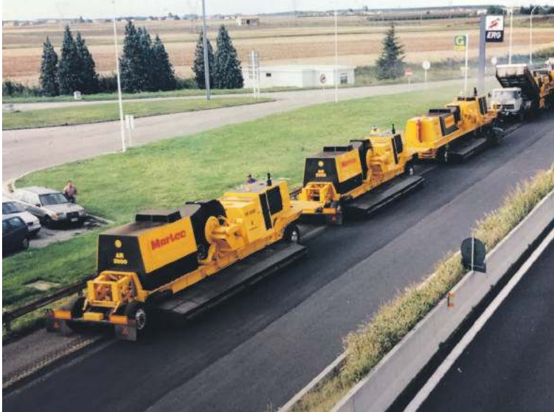
Pociąg Recyklingu Asfaltu. MARTEC AR 2000 podczas pracy na włoskiej autostradzie
