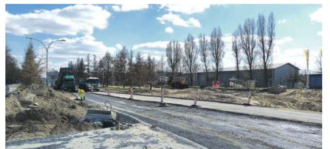
Zmodernizowana ulica Okulickiego będzie elementem nowego układu komunikacyjnego – tzw. zachodniej obwodnicy Stalowej Woli. Koszt remontu to 7,5 mln złotych
