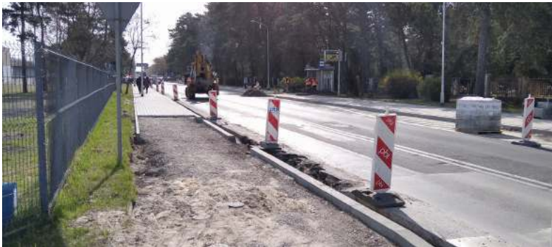
Zakres prac nad poprawą bezpieczeństwa niechronionych użytkowników ruchu jest większy niż tylko modernizacja samych przejść dla pieszych. Widać to na przykładzie ulicy Ofiar Katynia
