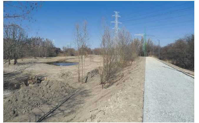
Termin zakończenia budowy Parku Zimnej Wody w Stalowej Woli to zgodnie z umową koniec czerwca tego roku. Koszt to 4,5 mln złotych
