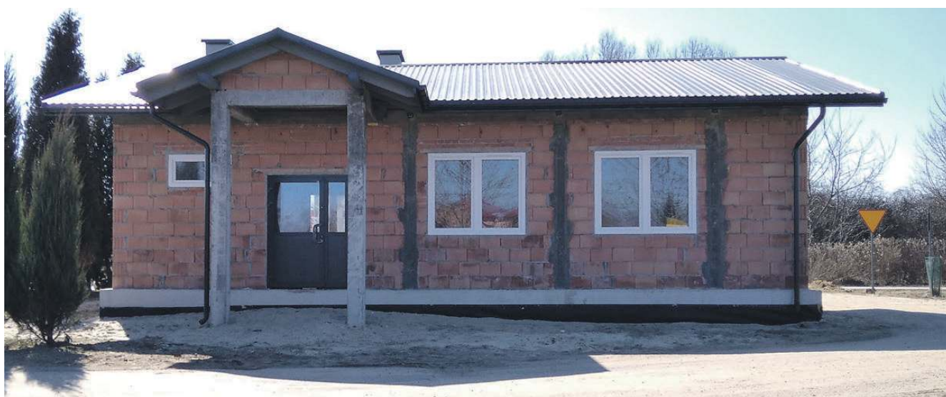
Ostatnim etapem przy realizacji tej inwestycji będzie wyposażenie świetlicy, które będzie sfinansowane ze środków funduszu sołeckiego miejscowości Chłopska Wola oraz środków własnych gminy
