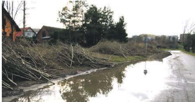
Remont ulicy Działkowej porządkuje zniszczoną już i kolizyjną w przebiegu infrastrukturę komunalną. Inwestycja pochłonie ponad 15 mln złotych
