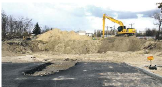
Zachodnia obwodnica miasta to rozwiązanie komunikacyjne, które ma wyprowadzić ruch z centrum Stalowej Woli i małych ulic. Koszt inwestycji to 32 mln złotych
