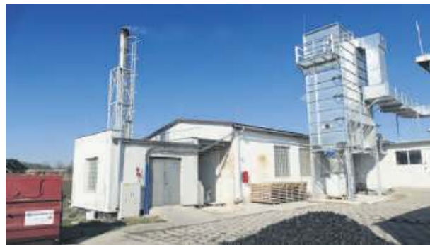
Zamiast tej kotłowni na terenie firmy Kessler ma stanąć nowa na odpady produkcyjne. Foto: archiwum Słowa
