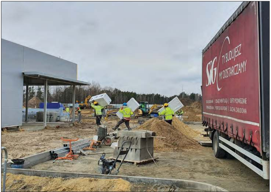
Prace budowlane przy stacji paliw i restauracji idą pełną parą. Na placu budowy działają wyspecjalizowane ekipy, które stawiają tego typu obiekty w całym kraju
