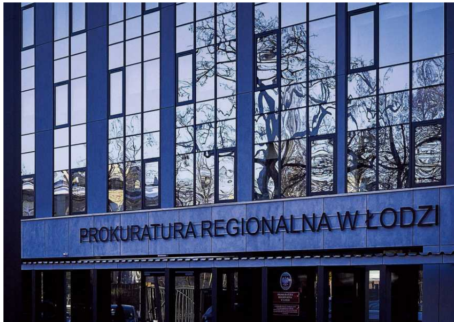
• Siedziba Prokuratury Regionalnej w Łodzi przy ul. Lipowej
