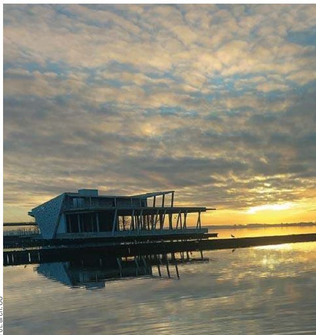
Niedokończona budowa restauracji na miejskiej plaży
