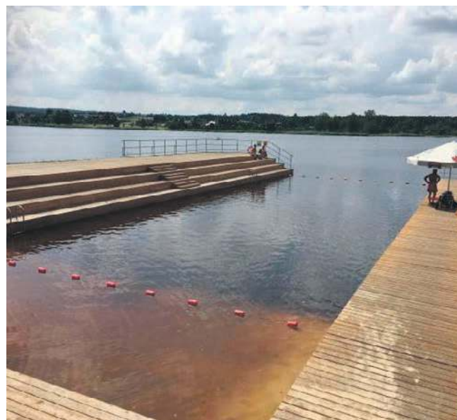
Zalew Chechło obecnie, po modernizacji
