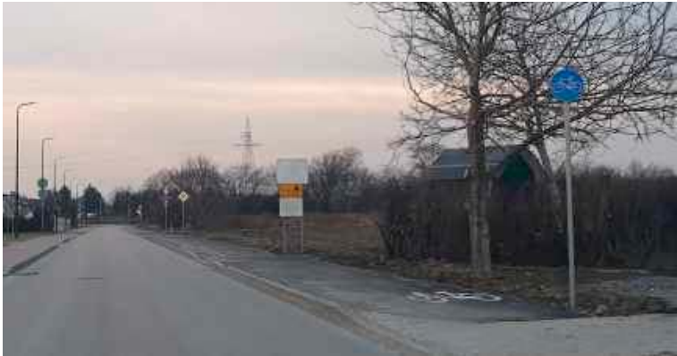
Budowa ścieżki rowerowej wzdłuż ul. Krańcowej kosztowała blisko 690 tys. zł
