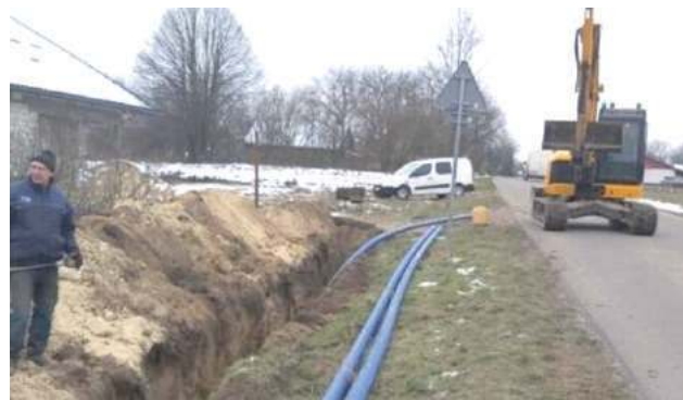
W Pulczynowie rośnie nowy wodociąg
