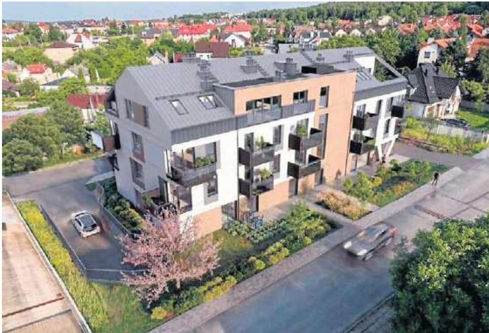
Osiedle Świerkowa w Kielcach to kameralny budynek z 19 apartamentami
