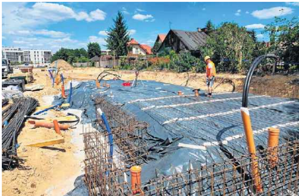
W strefie domów szeregowych specjaliści montują zbrojenie płyty fundamentowej
