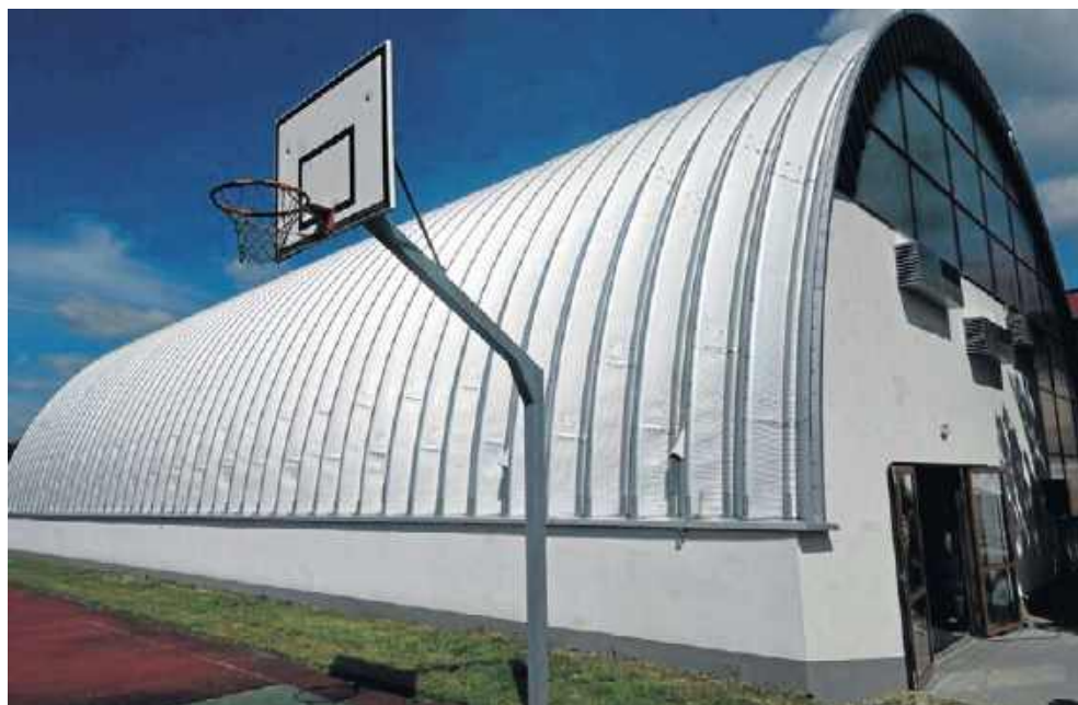
Całkowita wartość budowy hali sportowej w Kłudnie, wyniosła około 3, 7 miliona złotych. Dofinansowanie z programu Olimpij wyniosło ponad 2, 6 miliona złotych.
