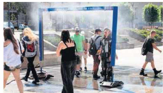
Rozpylana woda zapewniająca natychmiastowe obniżenie temperatury odczuwalnej dla przechodniów
