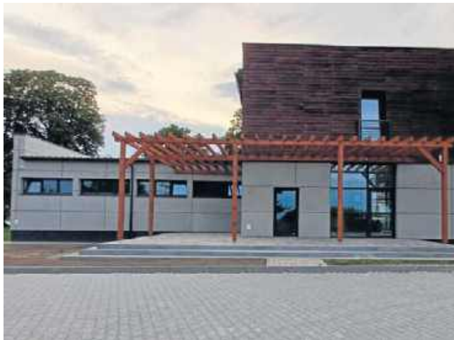
Przy wejściu do nowej biblioteki we Włostowie powstała taka konstrukcja
