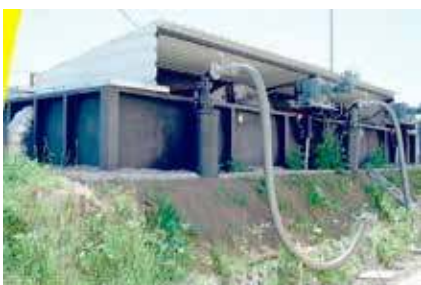
Podobnego typu oczyszczalnia stanie w Radzanku
