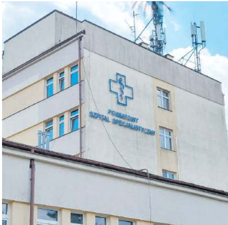
W wyremontowanych pomieszczeniach ma zostać ulokowana neurochirurgia
