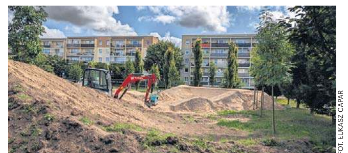
Budowa pumphacka na Osiedlu Niepodległości
