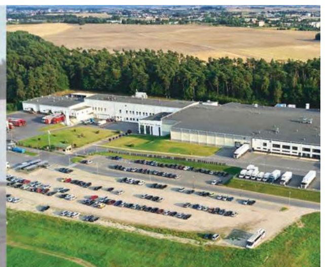
Ubojnia Trzody Chlewnej w Chojnicach.
