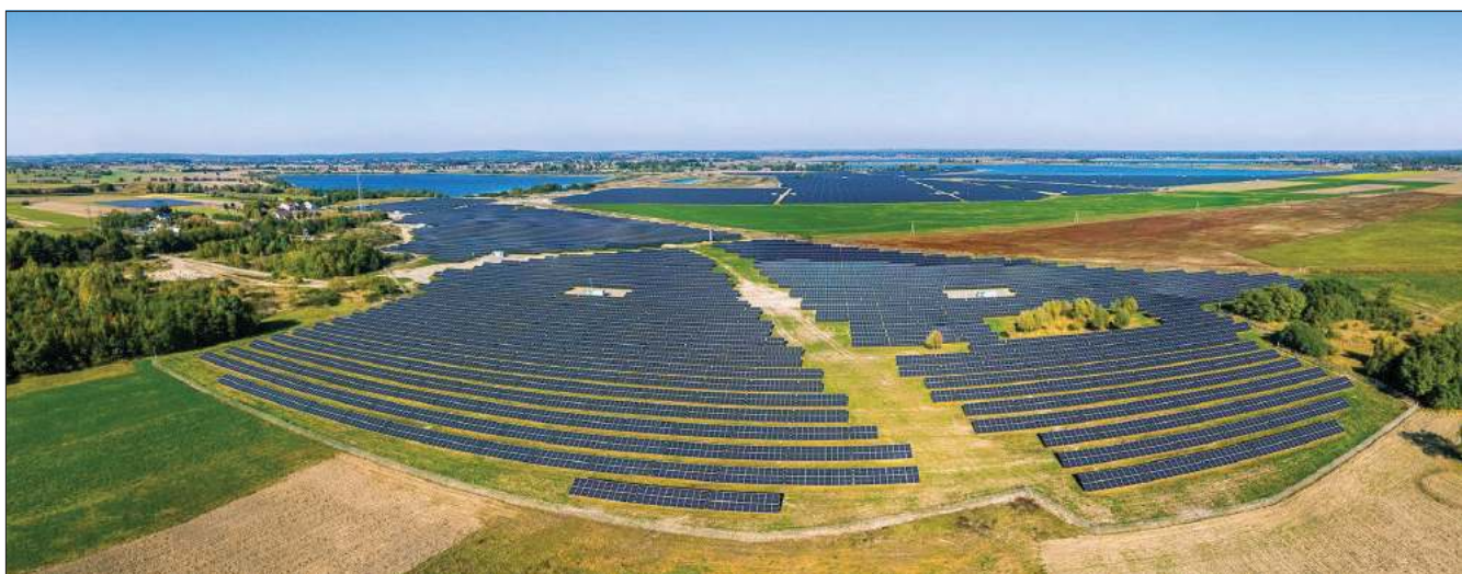
Farma fotowoltaiczna w Brudzewie to największa w Polsce elektrownia słoneczna. Zajmuje obszar 112 ha a jej moc nominalna to 70 MW. Składa się m.in. z 155 000 paneli.
