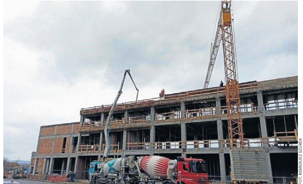
Budowa stadionu Sandecji postępuje, ale po drodze na jaw wychodzą kolejne nieścisłości
