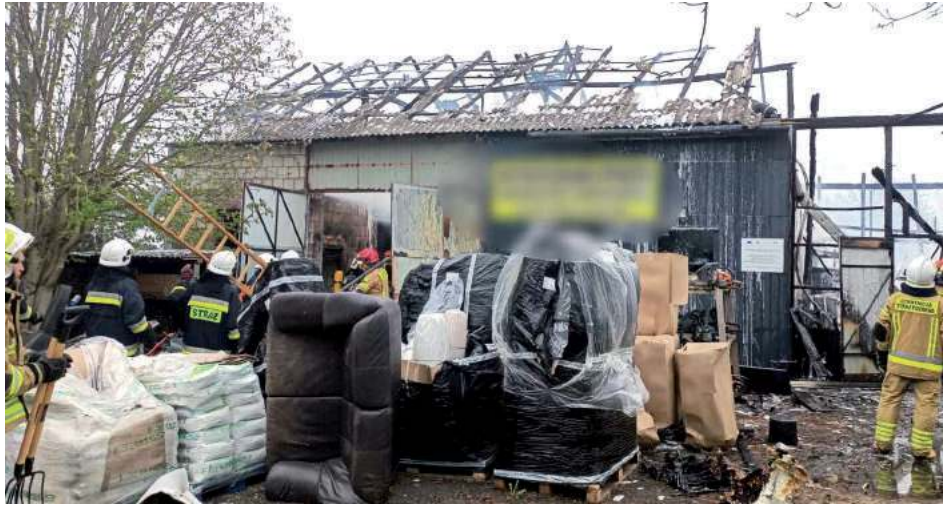
Właścicielowi budynku z poparzoną dłonią strażacy, założyli opatrunek hydrożelowy. Po akcji gaśniczej strażacy dogaszali i rozebrali więźbę dachową
