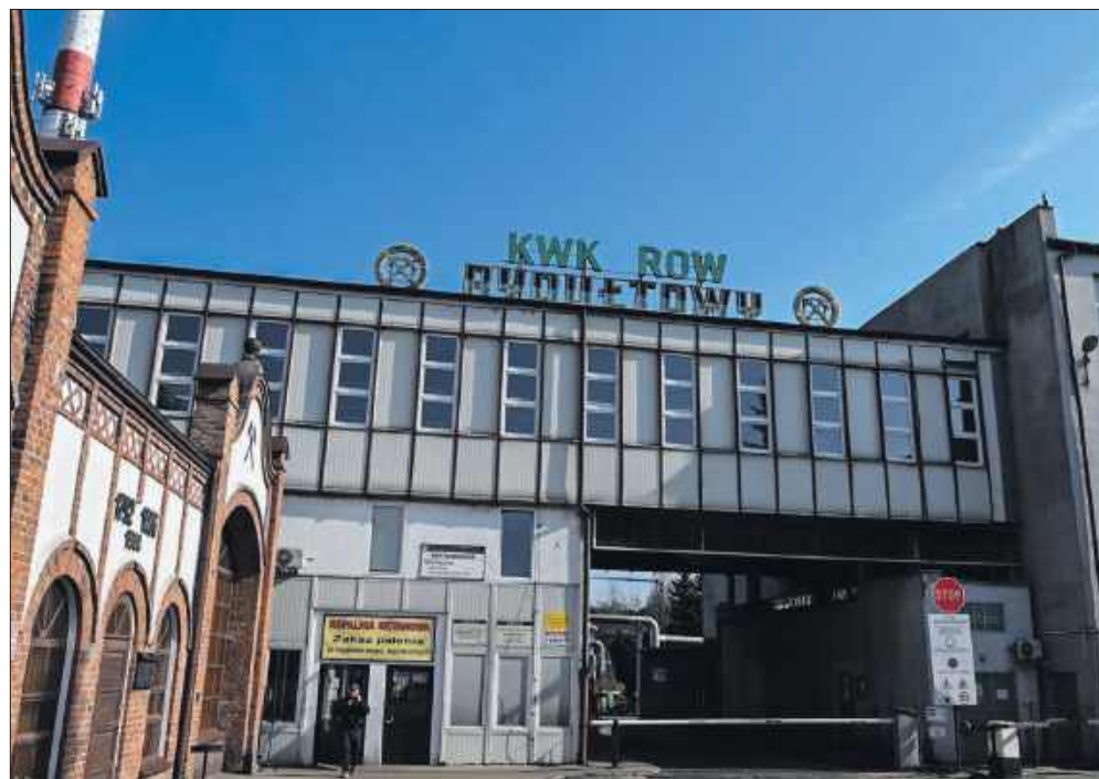
■ Wagonik stanie przed wejściem do kopalni
