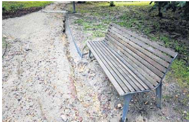
Woda wypłukała kilka warstw. Miejscami alejki bardziej przypominają koryta potoków niż spacerowe trakty
