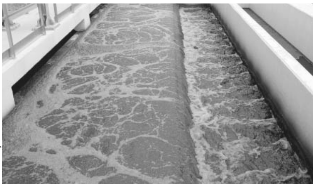
Oczyszczalnia ścieków w Mławie
