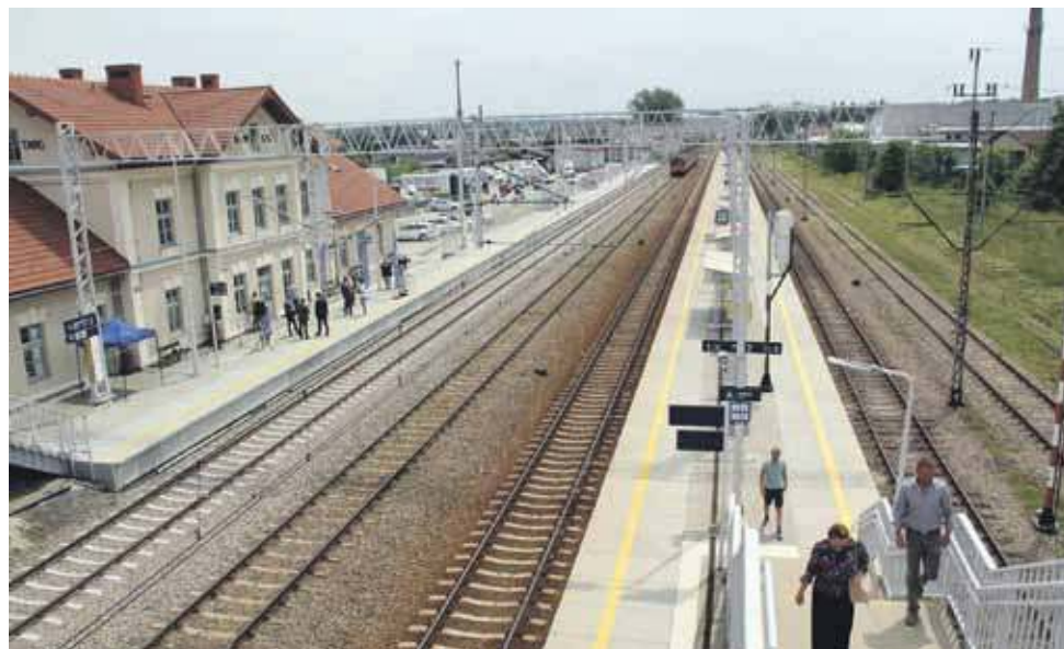
Nowy Targ wreszcie ma obydwa wyremontowane perony.
